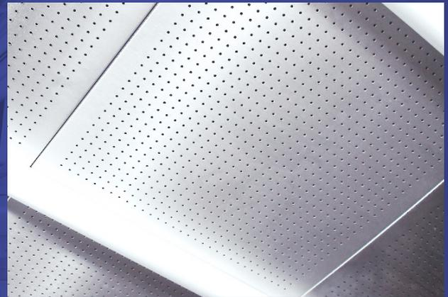
Die feine Perforierung der Zuluftkassetten sorgt für einen gleichmäßigen Druckverlust.
